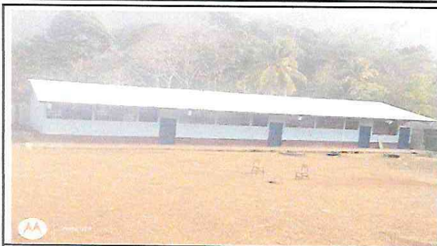
Foto 1: Se observa el edificio escolar con lamina nueva
