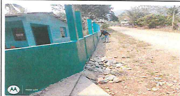
Foto3: Se observa muro perimetral terminado
