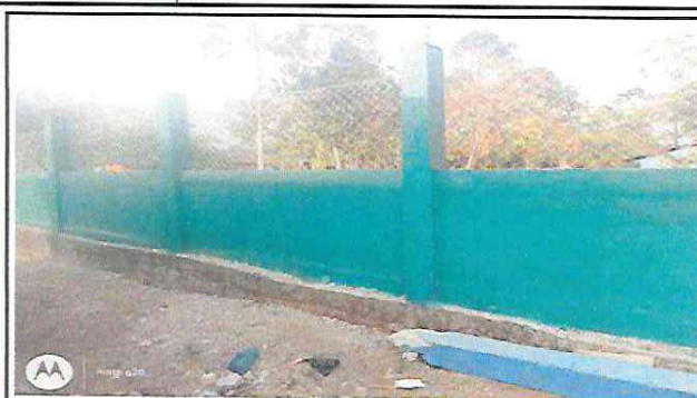
Foto 2: Se observa muro perimetral terminado
